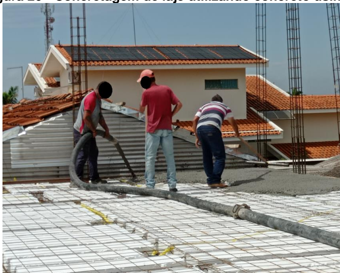
Figura 20 - Concretagem de laje utilizando concreto usinado
