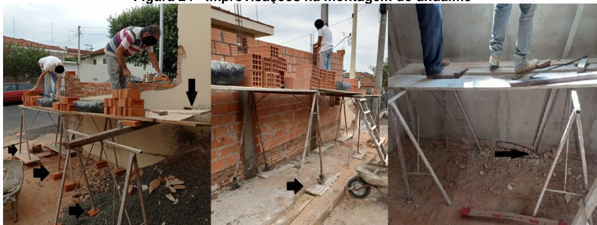
Figura 24 - Improvisações na montagem do andaime
