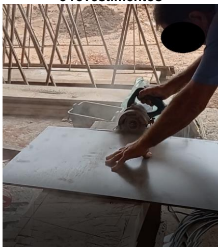
Figura 11- Poeira gerada em corte de pisos e revestimentos
