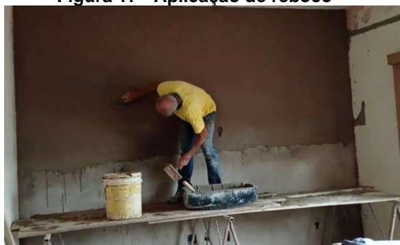
Figura 17 - Aplicação de reboco
