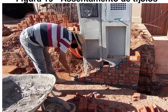
Figura 19 - Assentamento de tijolos
