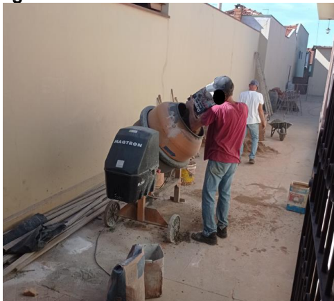
Figura 14 - Abastecimento de Betoneira
