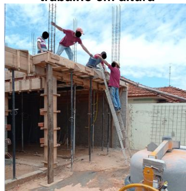
Figura 5 - Trabalhadores expostos em trabalho em altura
