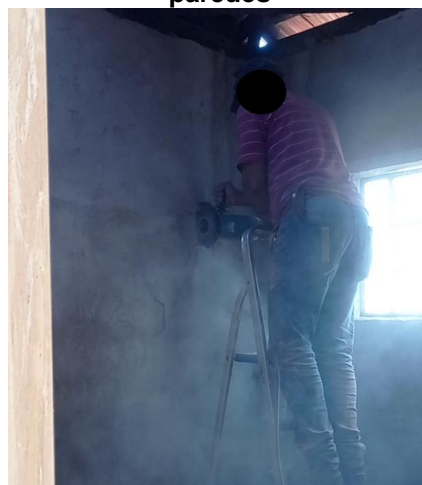
Figura 12 - Poeira gerada em corte de paredes
