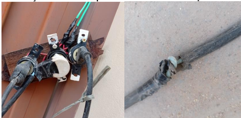
Figura 23 - Instalações elétricas improvisadas e má conservação de cabos elétricos
