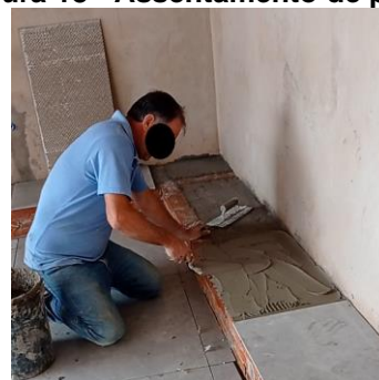
Figura 18 - Assentamento de pisos
